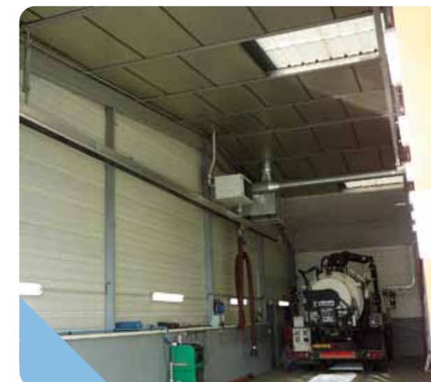
Rail avec décrochage Rail with disconnection
