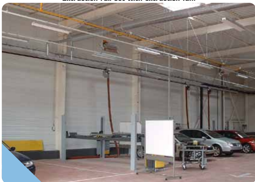
Centre de formation équipé d'un rail d'extraction. Formation Center equipped with extraction rail.
